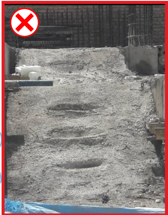
شکل ۱۸-۱: شکل دادن به بتن پله جهت کف پله
