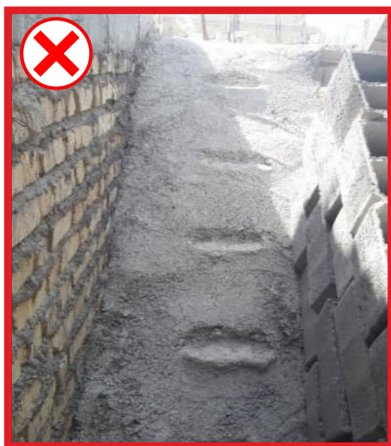
شکل ۲۲-۱: قرار دادن بلوک در راهپله در حین اجرای سازه
