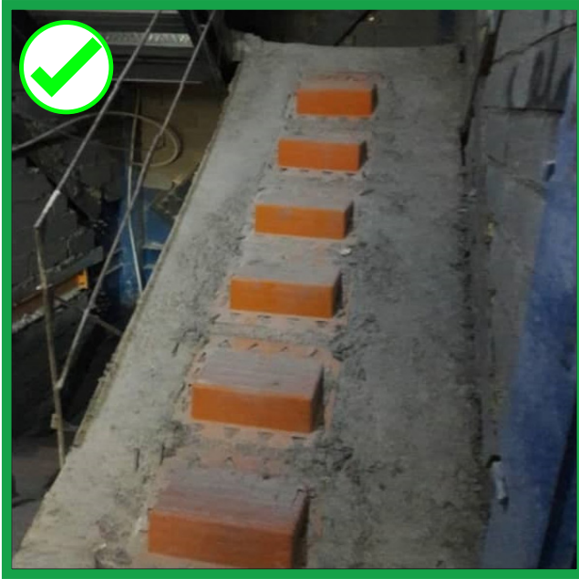
شکل ۲۰-۱: استفاده از پله‌های دسترسی جهت بالا رفتن از پله‌ها
