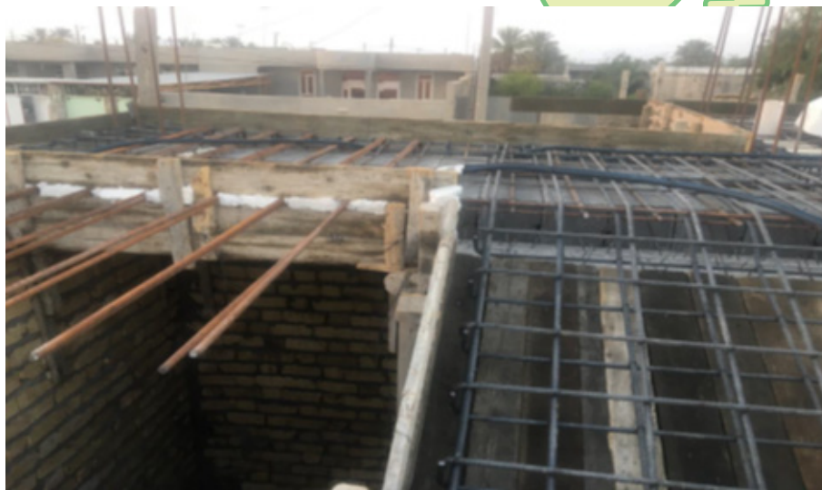
شکل ۱۰-۲: آرماتورهای انتظار پله در تراز سقف طبقه
