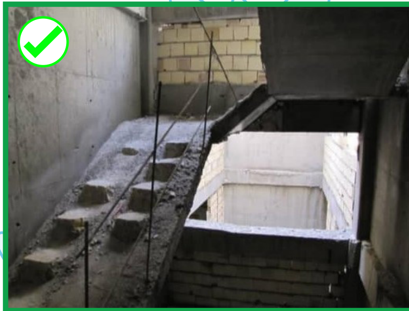
شکل ۲۱-۱: استفاده از پله‌های دسترسی دوطرفه
