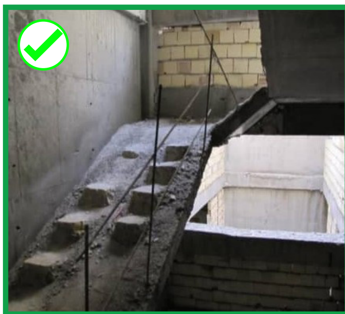
شکل ۲۱-۱: استفاده از نرده موقت در پله
