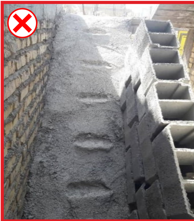
شکل ۱۸-۱: شکل دادن به بتن پله جهت کف پله
