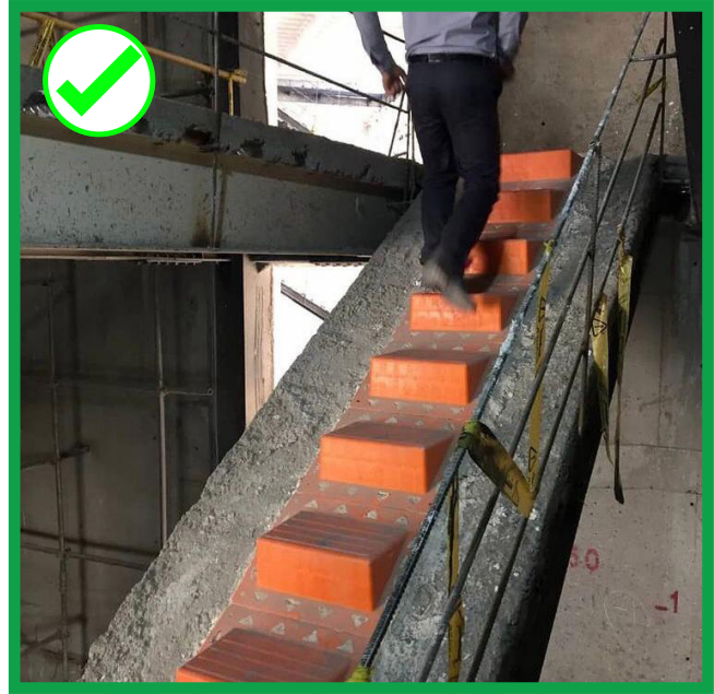
شکل ۲۰-۱: استفاده از پله‌های دسترسی جهت بالا رفتن از پله‌ها
